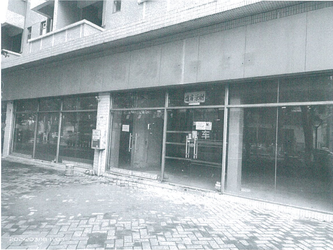
桂城街道瀚天科技城 A 区宿舍五首层 3、4 号铺
